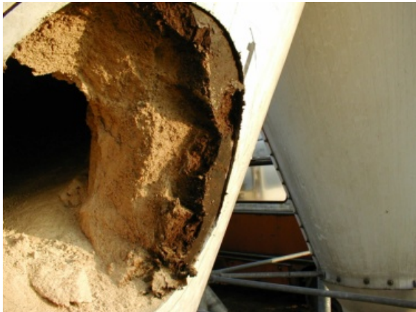
Bild 001: Ablagerungen und humose Schichten im Trichterbereich
