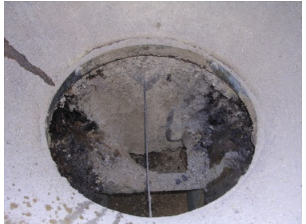
Bild 002: Hochgiftiger Gammel im Auslauftrichter/Entnahmetechnik
