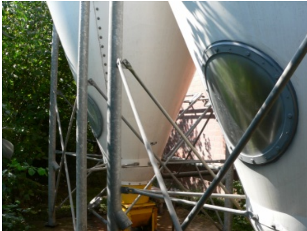
Bild 013: Silo-RoBoF ox – statisch geprüfte Zugangsöffnung
