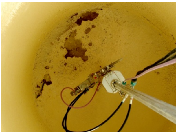
Bild 003: Staubablagerungen und humose Schichten im Deckelbereich Silo-RoBoFox im Silo
